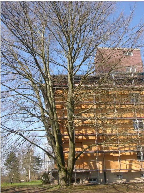
Fahrspuren bei Baumaßnahmen im Wurzelbereich der Rotbuche
